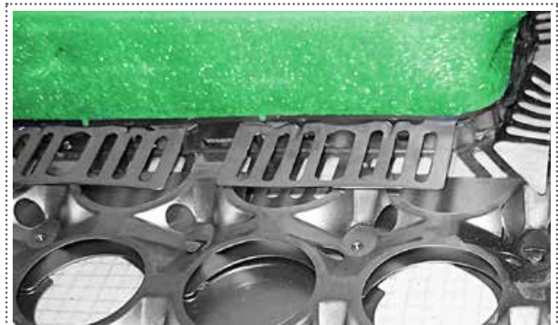
4 Halteklammern (HK) in Randdämmstreifen (mind. 3 Stück / m) einsetzen.
