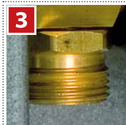
Anbindung Heizungsanlage Vorlauf V
