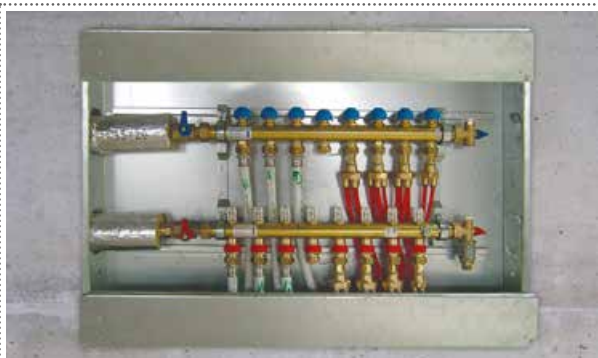
Etagenverteilung mit handelsüblichem Mehrfachverteiler (Bild links) und effidur HKV-VA (Bild rechts) bestückt mit Unterverteilern.
