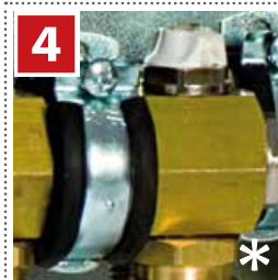
Anbindung Heizungsanlage Rücklauf R (hinterer Balken)
