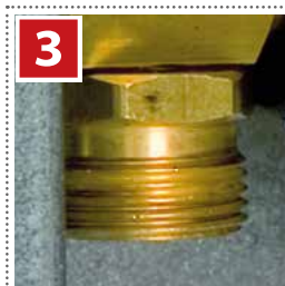
Anbindung Heizungsanlage Vorlauf V
