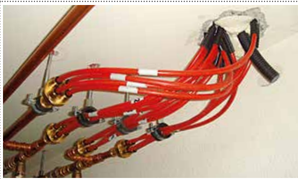
Zonenweise Unterverteilung durch die Decke.
