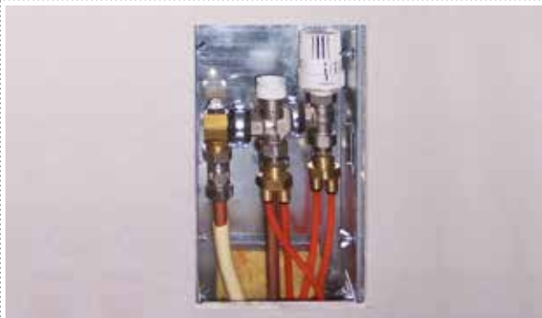
Regelbox Variante 2 mit Unterverteiler 2-fach.
