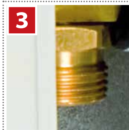
Anbindung Heizungsanlage Vorlauf V
