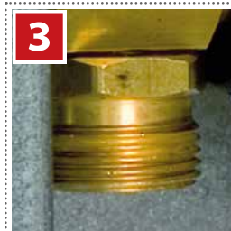
Anbindung Heizungsanlage Vorlauf V
