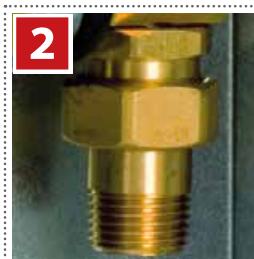
Rücklauf Fußbodenheizung mit Verschraubung Eurokonus
