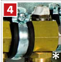
Anbindung Heizungsanlage Rücklauf R (hinterer Balken)
