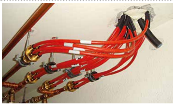
Zonenweise Unterverteilung durch die Decke.
