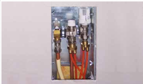
Regelbox Variante 2 mit Unterverteiler 2-fach.
