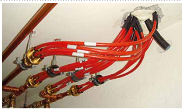
Zonenweise Unterverteilung durch die Decke.
