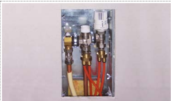
Регулирующий блок, вариант 2 с двухканальным вторичным распределителем.
