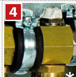
4 Присоединение обратной линии системы отопления R (задняя балка)
