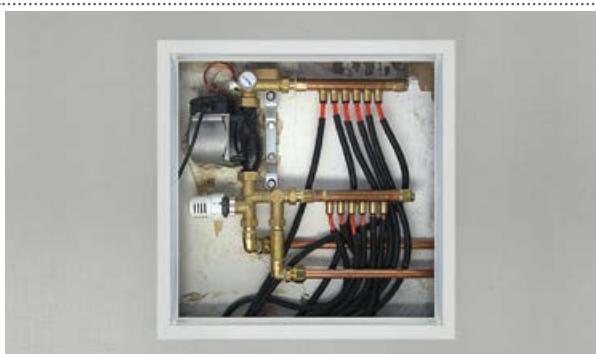
Блок распределителей шестиканальный на регулирующем узле.
